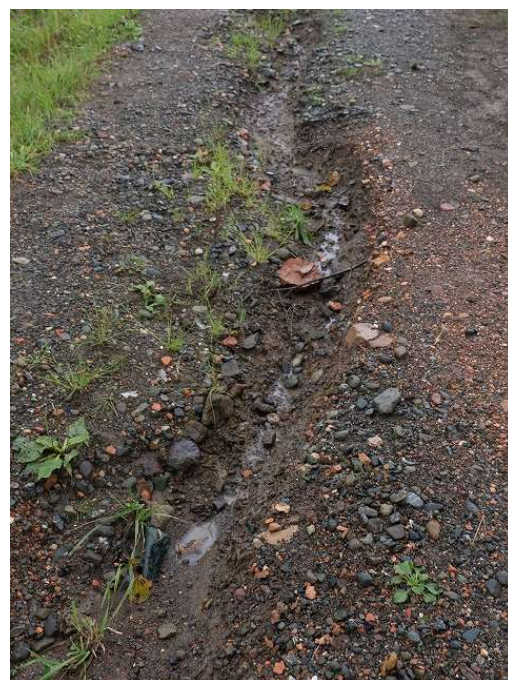
(至る所に地割れがあります)
